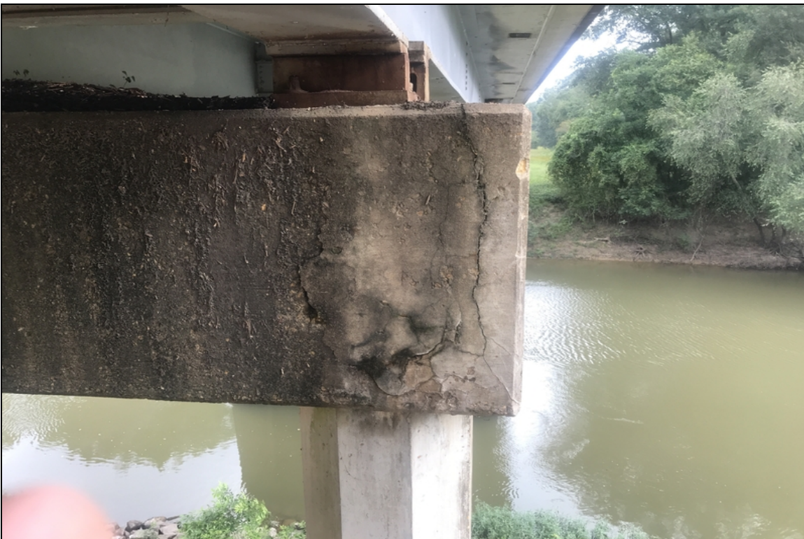
Bent 25 cap right side delam
